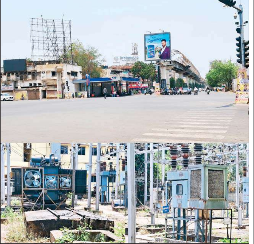
रायपुर, 20 अप्रैल। गर्मी के चलते इन दिनों राजधानी की सड़कें सूनी नजर आ रही है। वहीं विद्युत ट्रांसफार्मरों को गर्मी से बचाने के लिए कूलर का उपयोग किया जा रहा है।
